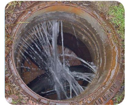
**Grundwassereintritt im undichten Kanalschacht.**
